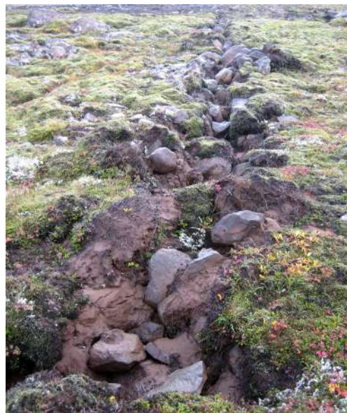
Sár eftir plógfar vegna lagningar jarðskautsborða.
